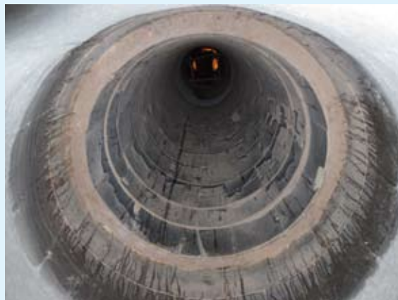
Рис. 2. Противоабразивная защита корпуса вертикальной трубы-сушилки
